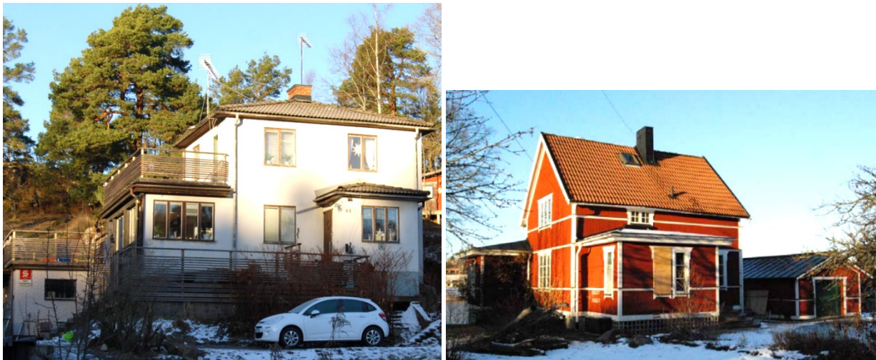
Bild 12. Funkisvilla (till vänster) och villa med egnahemskaraktär (till höger).
