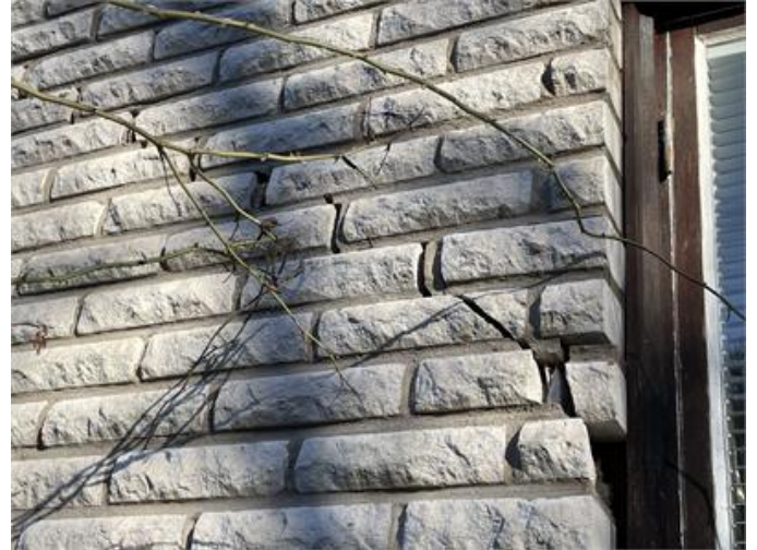
Sprickbildning/skador fasad.
