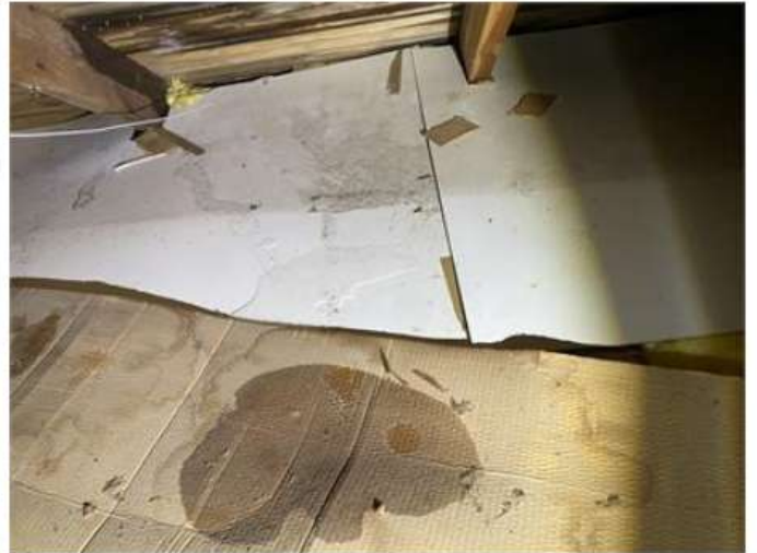
Fuktfläckar och fritt vatten på pappskivor.
