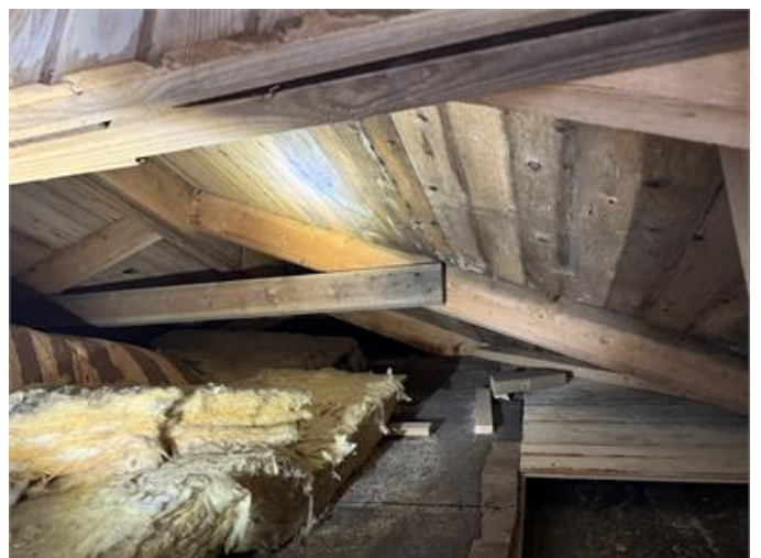
Mikrobiell påväxt förekommer på underlagstakets insida i vindsutrymme.
